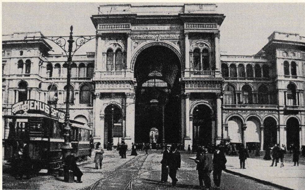
Piazza del Duomo e ingresso della Galleria Vittorio Emanuele inizio '900 (sul lato destro dell'arco centrale le finestre dell'abitazione di Anna Kuliscioff dal 1892 al 1925)
